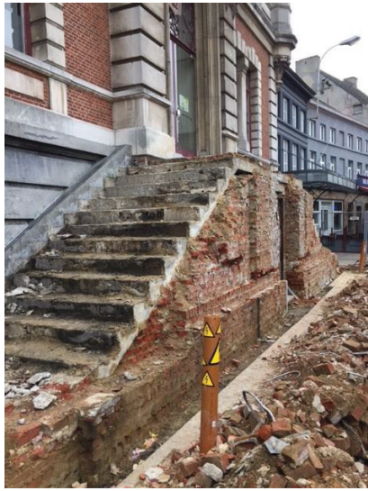
De ontmanteling van de oude pui.
