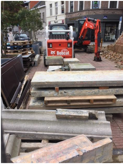
De ontmanteling van de oude pui.
