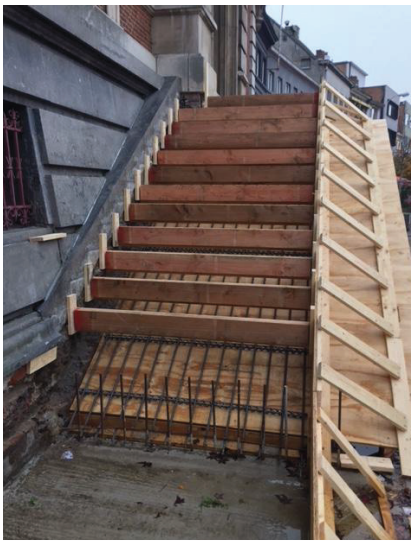
De bekisting van de nieuwe pui.
